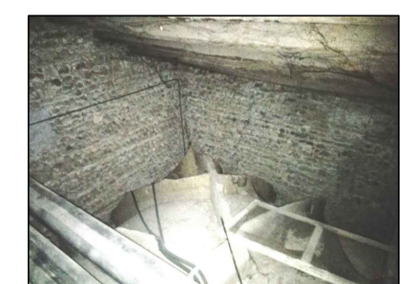
FOTO 9, ZONA 1B COPERTURA INCLINATA CON CONTROSOFFITTO A VOLTA NON PRATICABILE.
