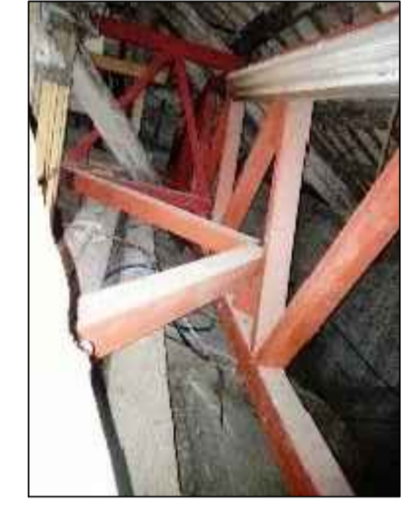
FOTO 21, ZONA 2D PARTICOLARE DELLA SOFFITTA SOPRA LA SALA DELLA STUFA, CON STRUTTURA METALLICA DI RINFORZO PERMETRALE. CONTROSOFFITTO A PAVIMENTO NON CALPESTABILE.
