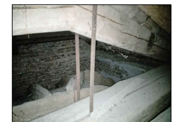
FOTO 8, ZONA 1A CAPRIATA DELLA COPERTURA E CONTROSOFFITTO A VOLA NON PRATICABILE.
