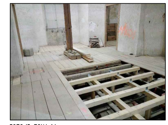
FOTO 15, ZONA 6A FUTURI UFFICI. SI VEDE LA PARTE LIBERA DEL PAVIMENTO PER ACCESSO ALLA ZONA 4 (CONTROPAVIMENTO).
